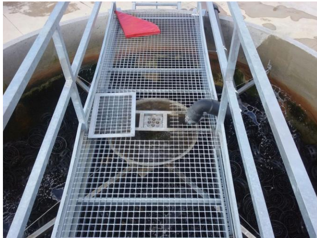
Foto: Distribución del agua mediante el brazo giratorio
