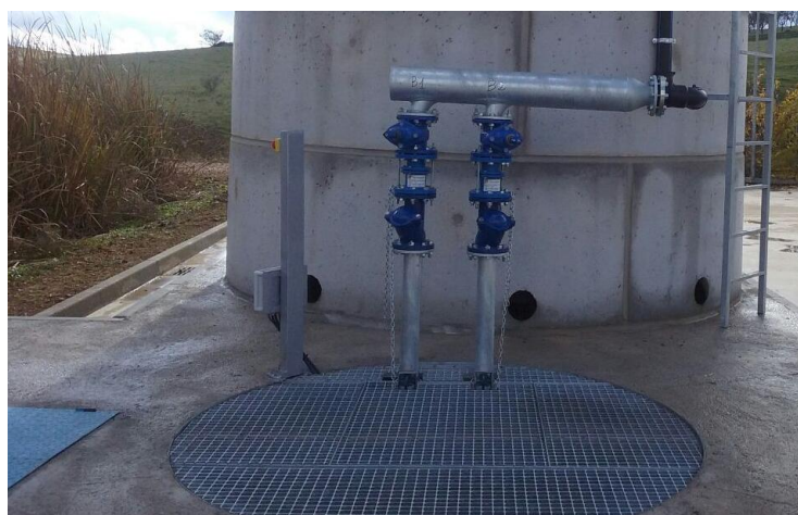
Foto: Arqueta con dos bombas que impulsan el agua al lecho
