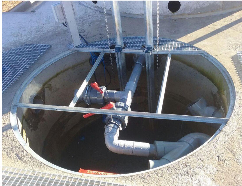
Foto: Conexiones de salida del lecho al bombeo y/o balsa FMF
